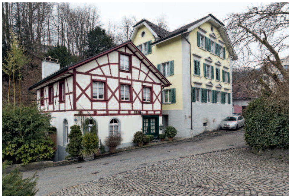
Die Liegenschaft Mühleweg 1 im aktuellen Zustand.
